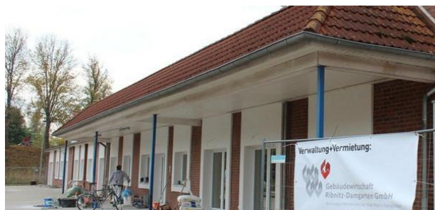
nach dem Umbau (kurz vor Fertigstellung)
