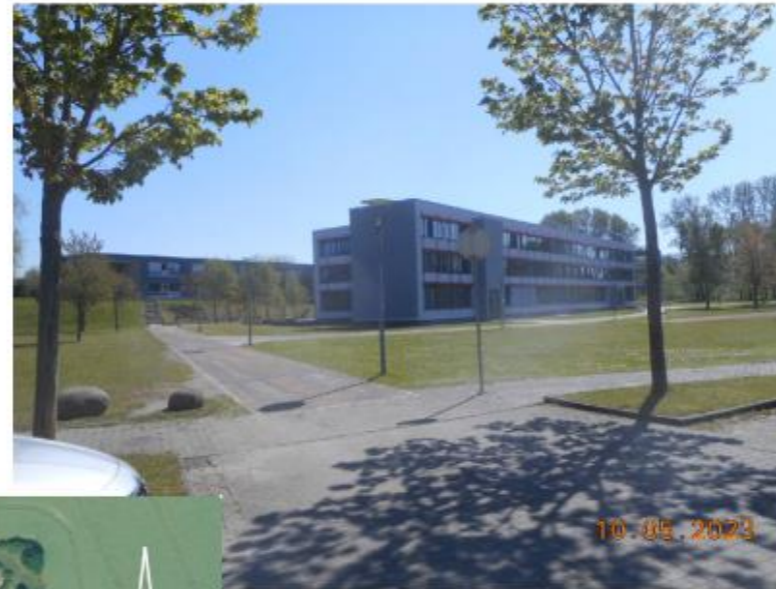
Gymnasium von der Westseite gesehen
