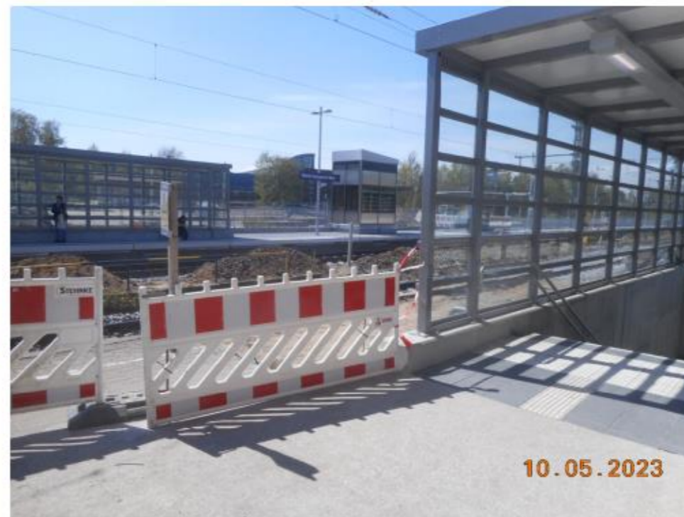
Personenunterführung im Bau
