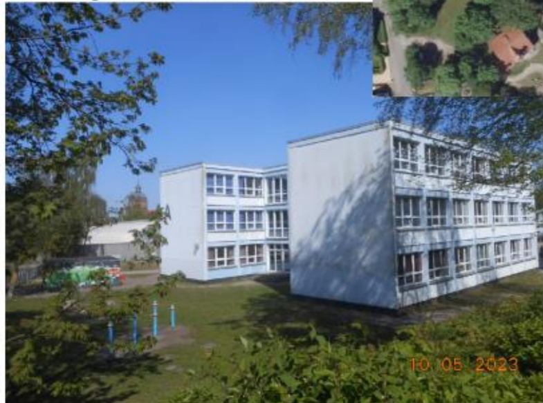
Blickrichtung Osten im Hintergrund die alten Turnhalle
