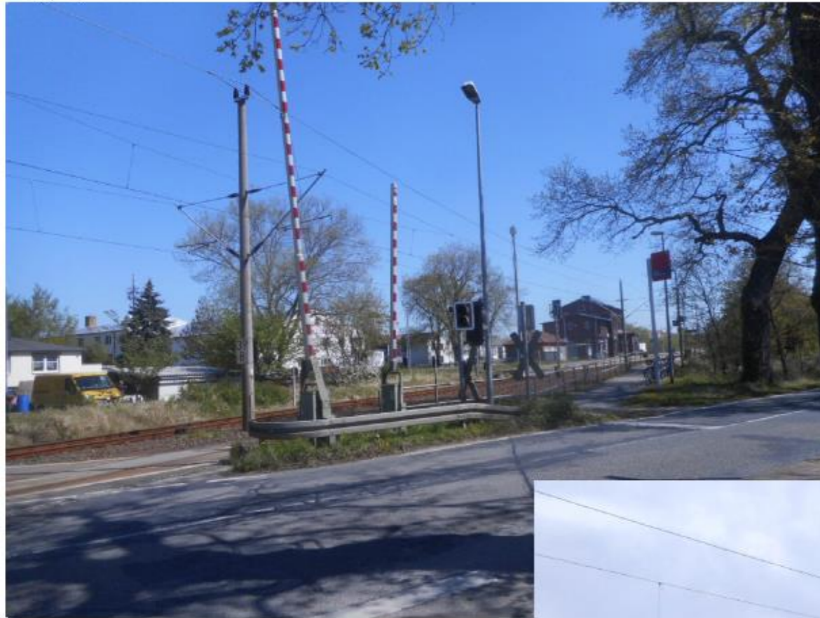
Zugang zu Gleis 2
