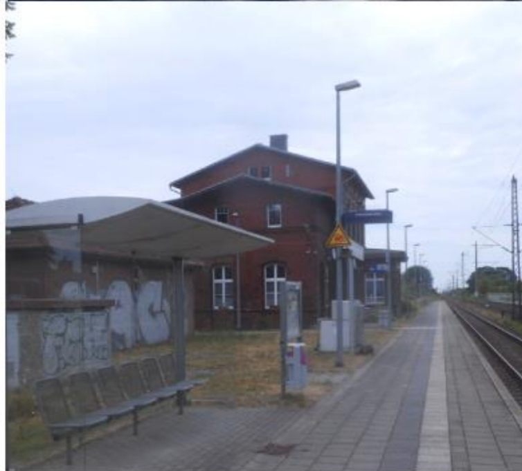
Gleis 1 mit dem ehem. Bahnhofsgebäude
