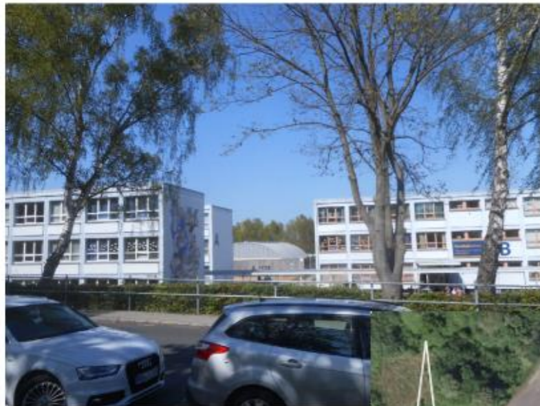
Blickrichtung Norden im Hintergrund die alte Turnhalle
